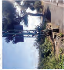
Traffici del filobus a rischio crollo sulle strade: ieri è successo a Bordighera. Ora ecco un altro a rischio a Sanremo (Polo) ANSA/AGF/AGF 10 Settembre 2019 16:00 - 2 Anni di Storia
