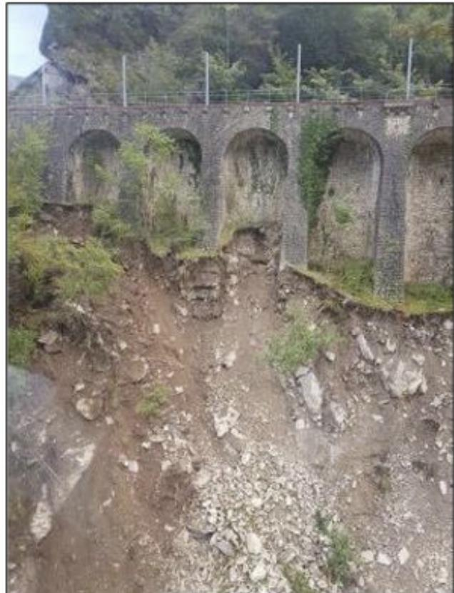
Erosione alla base del muro ad archi al km 69+217, a nord della stazione di Fontain La Sorge
